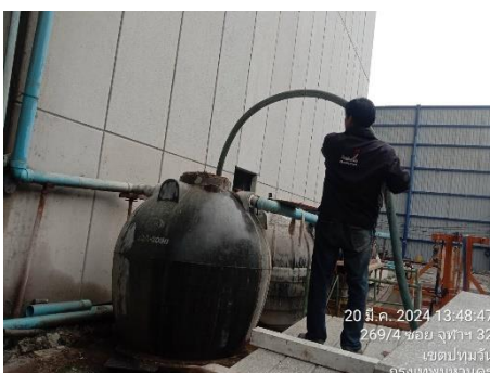
ภาพที่ 2.2-49 สำนักงานเขตปทุมวันเข้ามาสูบน้ำส่วนเกินจากระบบบำบัดน้ำเสียไปกำจัด
