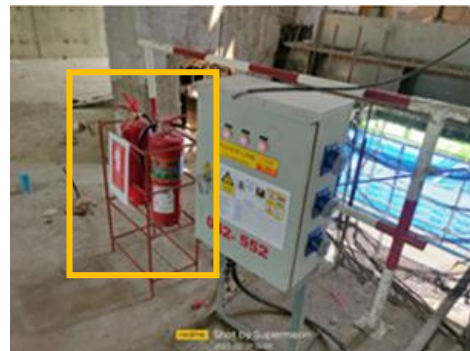
ภาพที่ 2.2-33 ถังดับเพลิงบริเวณกิจกรรมที่มีประกายไฟ และความร้อน
