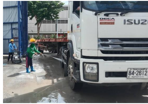
ภาพที่ 2.2-10 พื้นที่ล้างล้อรถบรรทุก
