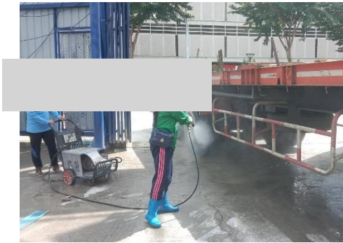
ภาพที่ 2.2-10 พื้นที่ล้างล้อรถบรรทุก
